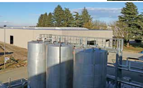
The new 2,400 square-meter warehouse facility La nuova struttura di 2400 metri quadrati destinata a magazzino
